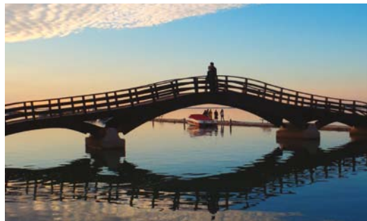
Το γεφυράκι στο δυτικό μόλο
