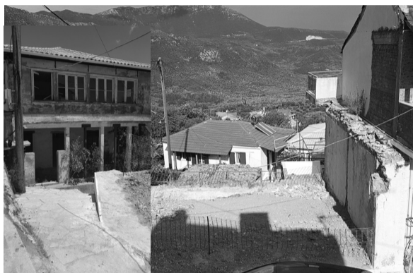
Ο χώρος μετά την κατεδάφιση, αριστερά το Κοινοτικό
